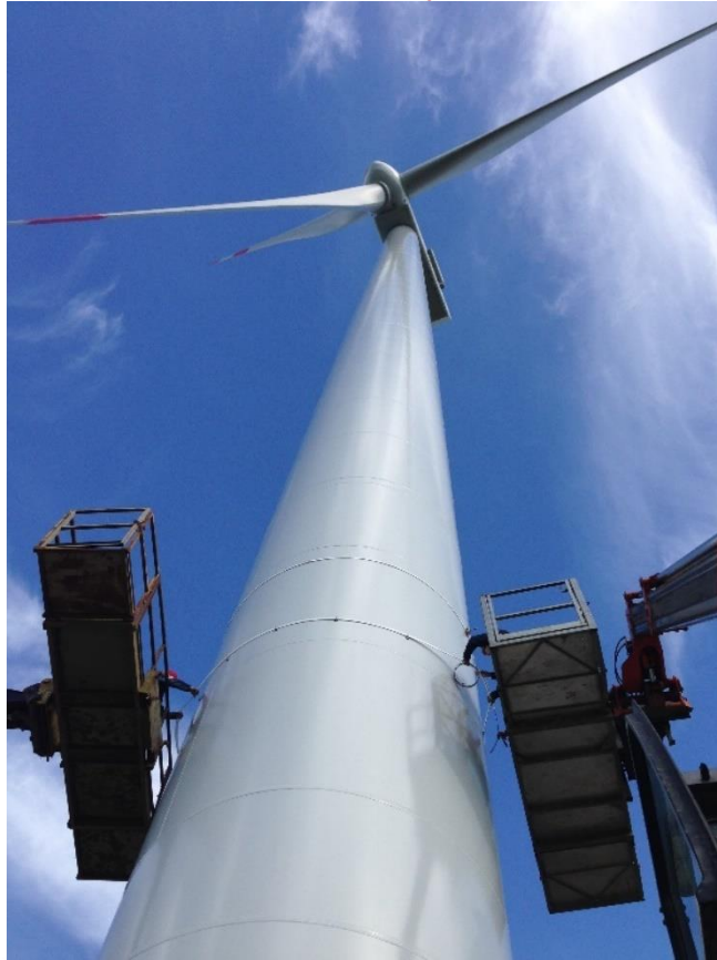
Abbildung 5: Befestigung / Abnahme von Spannringen an einer Windkraftanlage
