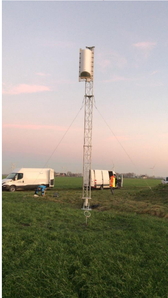
Abbildung 7: Beispiel Befestigung der Antennen an einem separaten Mast
