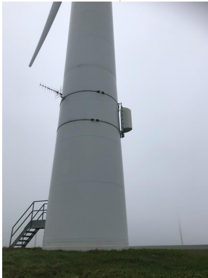
Abbildung 4: Beispiel Befestigung der Antennen an einer Windkraftanlage
